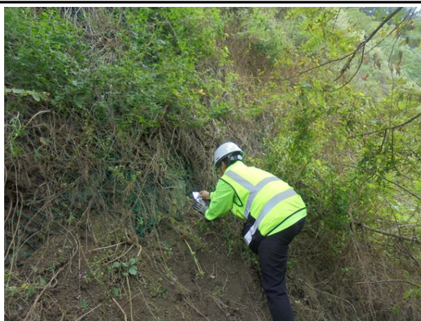
절리면 경사/경사방향 측정
